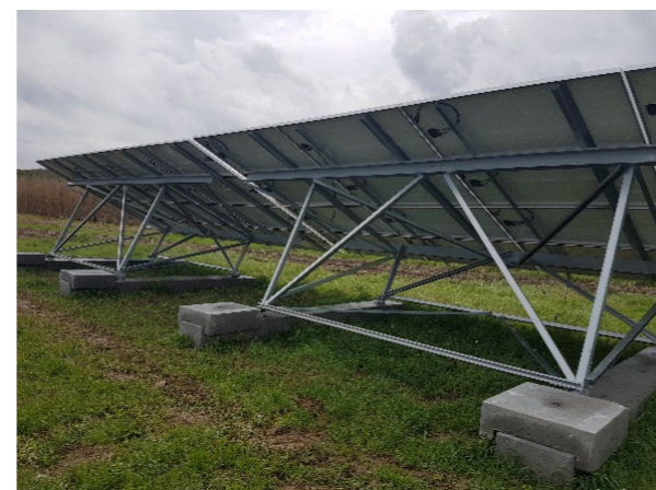
Figure 6 : Exemple de fondations béton (Source : RES)
